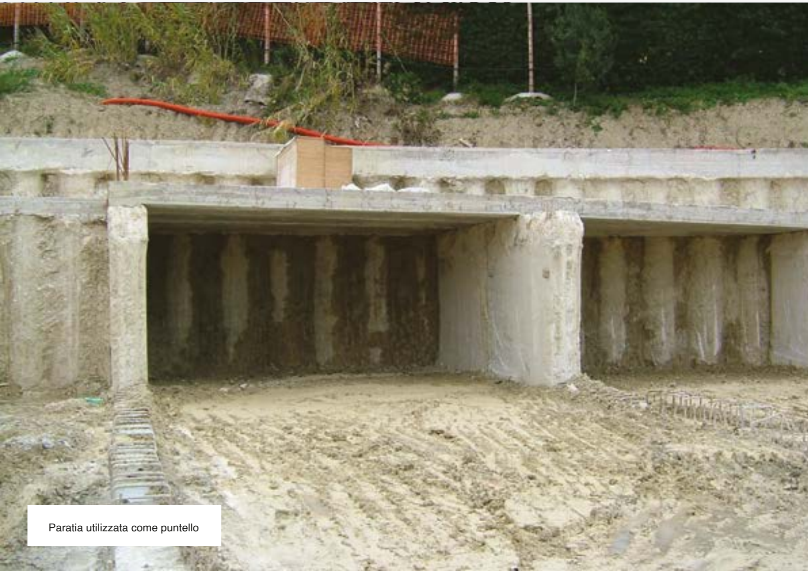
Puntellamento diaframmi con strutture metalliche
