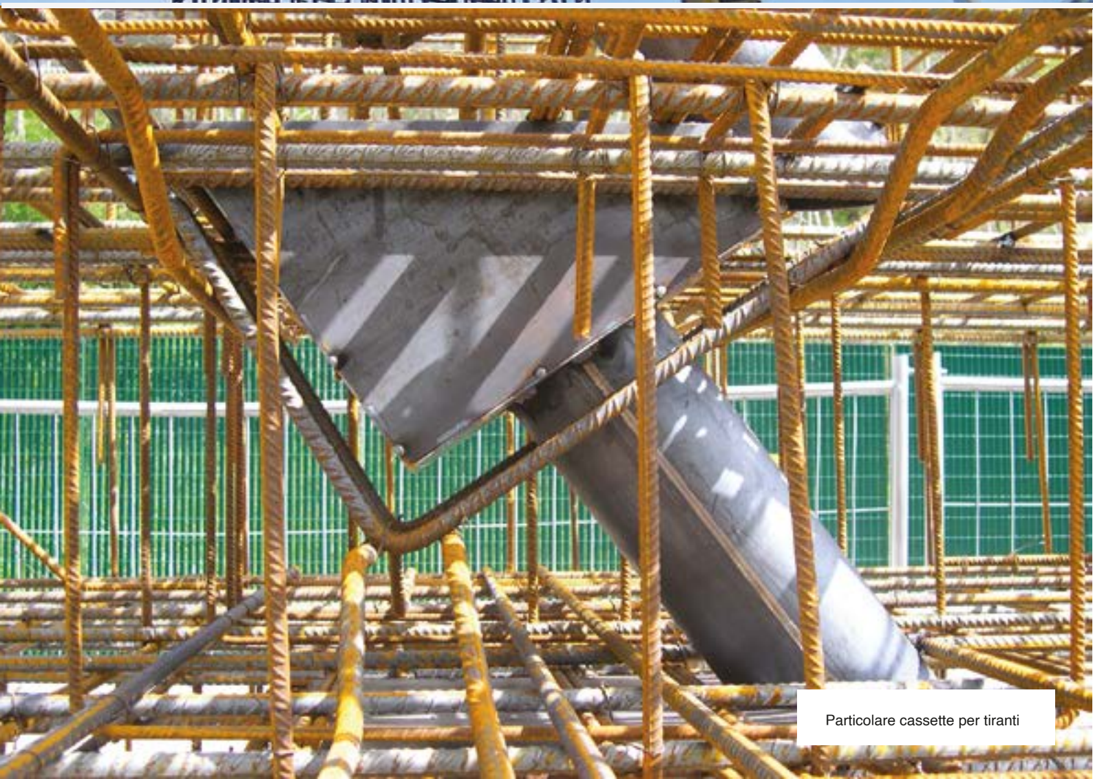
Particolare cassette per ripresa solaio
