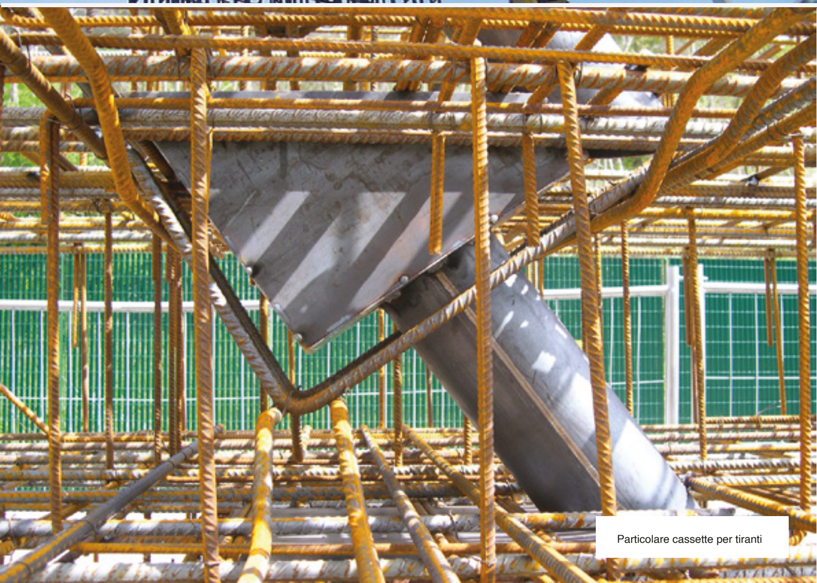
Particolare cassette per ripresa solaio
