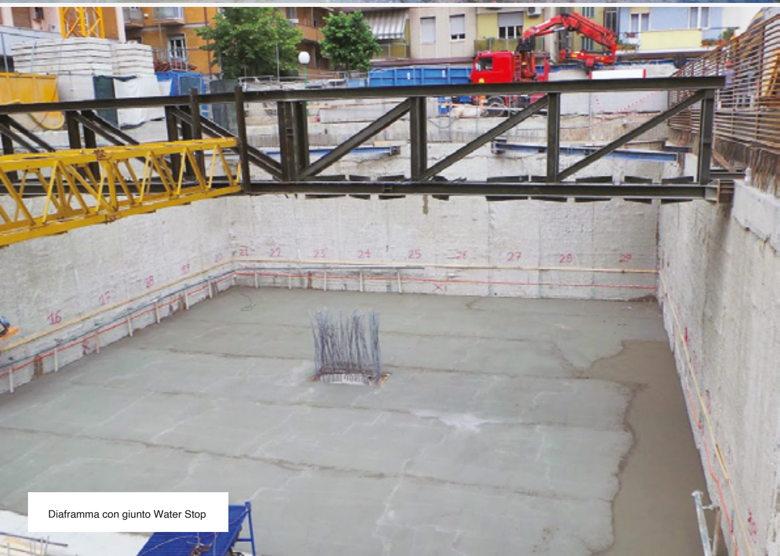
Diaframma eseguito su un torrente a Pordenone
