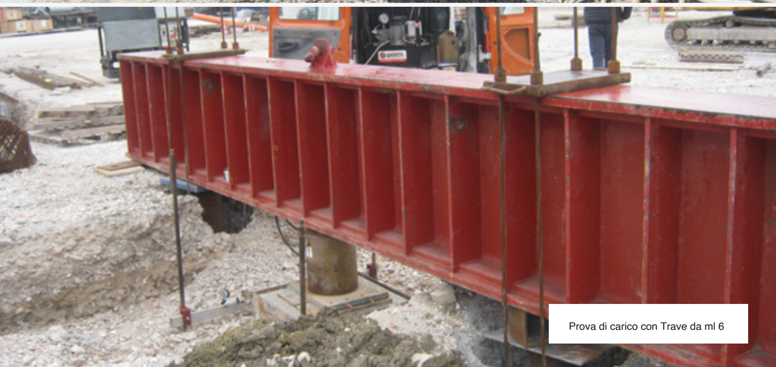
Prova di carico con 2 travi
